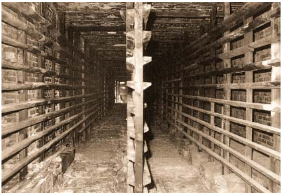
Le fornaci di Boscherina: dettaglio interno, essiccatoio (Foto Comune di Novazzano).
