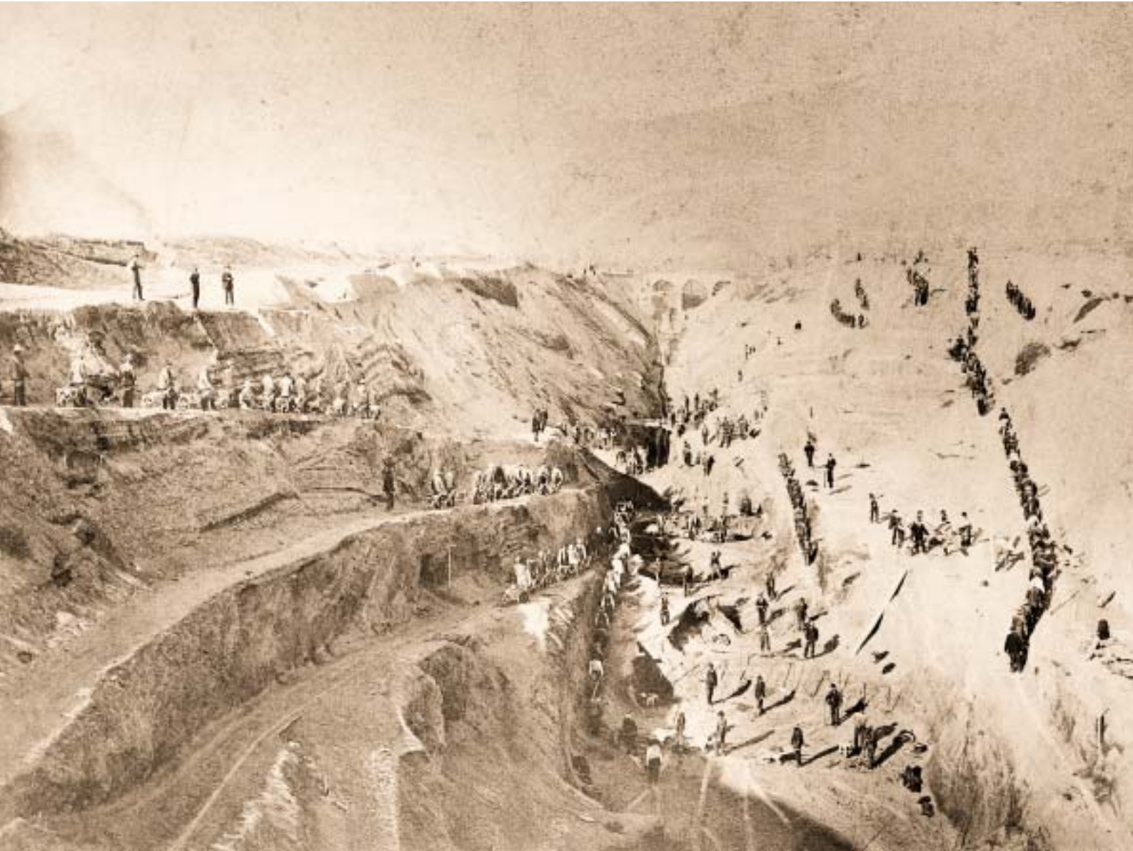
La Trincea d'«Approccio Nord a Coldrerio» (AS, Fototeca, Bellinzona).
