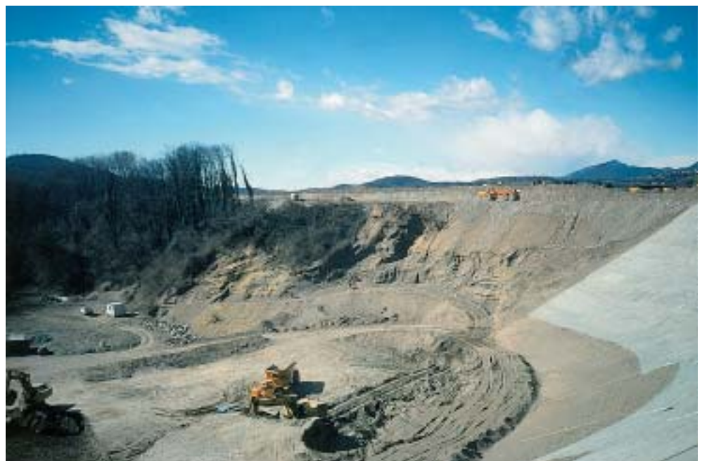
Veduta parziale della ex-cava nella parte centrale della Valle della Motta (settore W) all'inizio dei lavori di sbancamento e di riporto (Foto M. Felber, marzo 1990).
