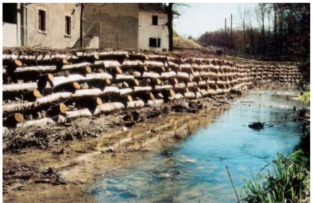
Argine a lato del Mulino Daniello (Foto I. Camponovo).
