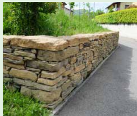
Muretto a secco di contenimento, Via Vigna.
