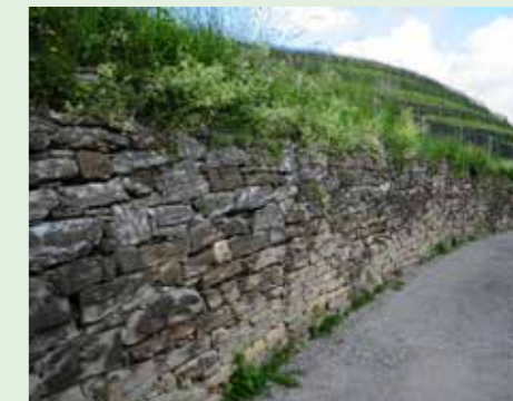
Muretto a secco di contenimento, Alla Costa.
