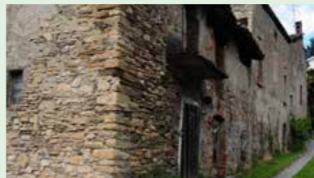
Caseggiato rurale costruito con muratura in flysch mista a laterizi, Via Möja.
