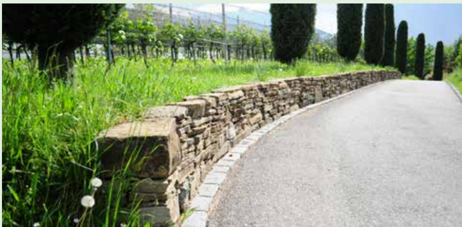
Viale con muretto a secco di contenimento e decorativo, Via Vigna.
