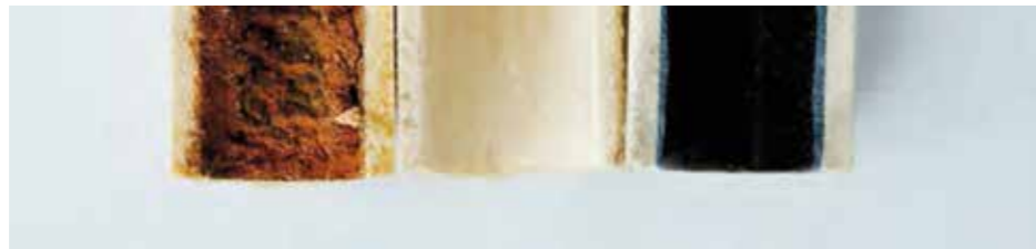
Un tubo del riscaldamento prima, durante e dopo il risanamento
